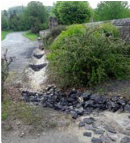
Aménagement à Monchy-Humières, au niveau du cimetière
