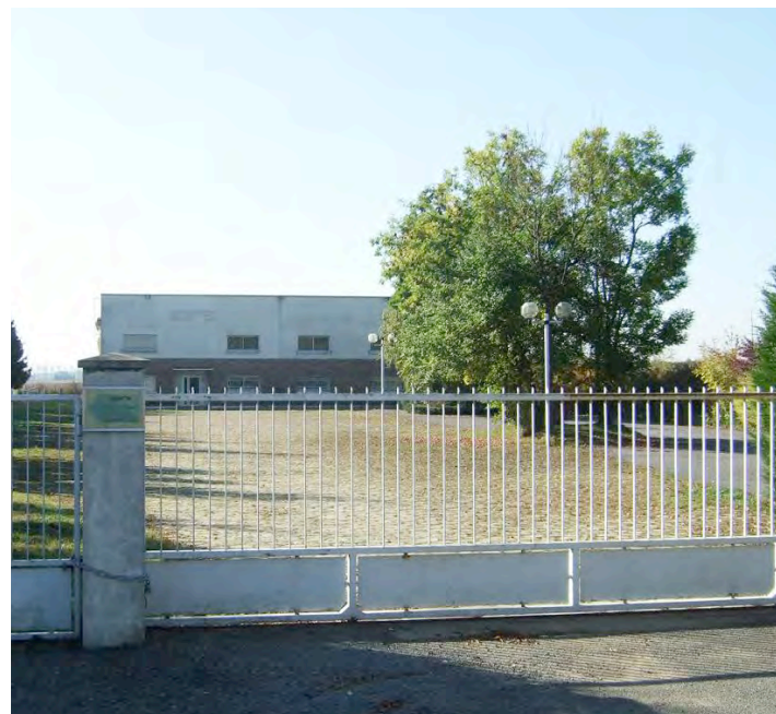
Locaux industriels libres, éloignés des habitations.
